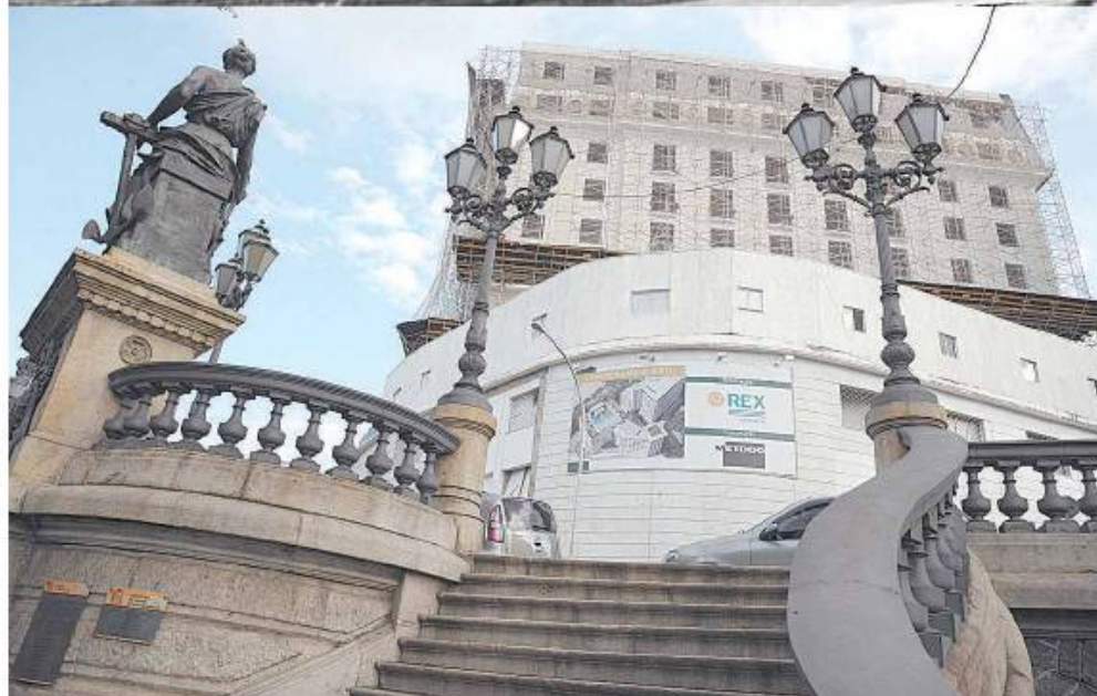
O Hotel Glória nos seus tempos áureos (no alto) e hoje, em meio a uma obra inacabada
