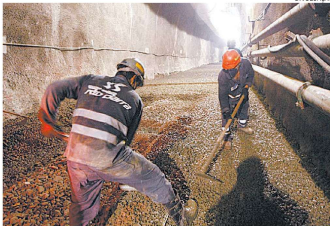
Operário já escavam túnel da Linha 4 entre S. Conrado e Barra da Tijuca
