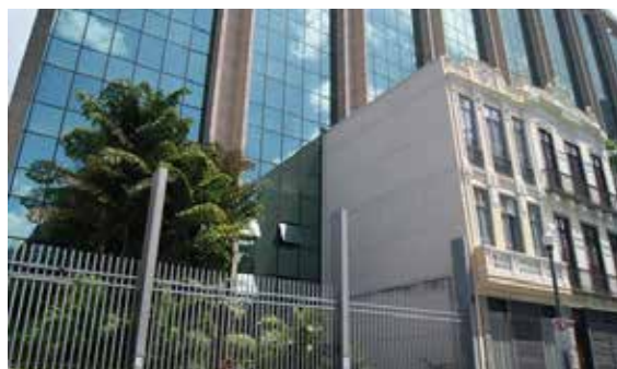
Figura 14 - Rio de Janeiro - Rua do Lavradio, 132
